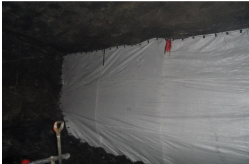
Rys. 1. Zainstalowana samonośna tama DSI DAM BAG w podziemnym wyrobisku górniczym.
