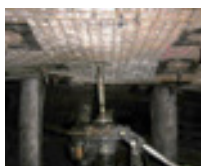
Wiercenie otworu Ø 42 [mm]
