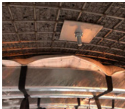
Rys. 3. Mocowanie worków za pomocą pasków do obudowy podporowej.
